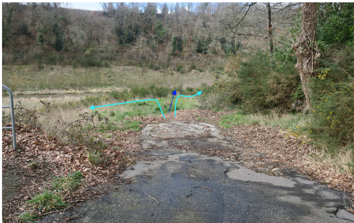
Bas du parking de la Masure – écoulements actuels (bleu ciel), travaux prévus (drain enterré en bleu foncé) (DDTM50).
